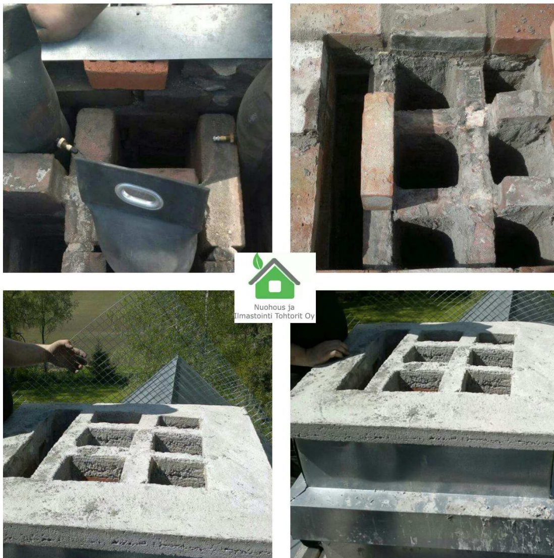
Kuvasarja 3. Malliesimerkki savuhormien korjauksen havainnollistavasta kuvasarjasta
