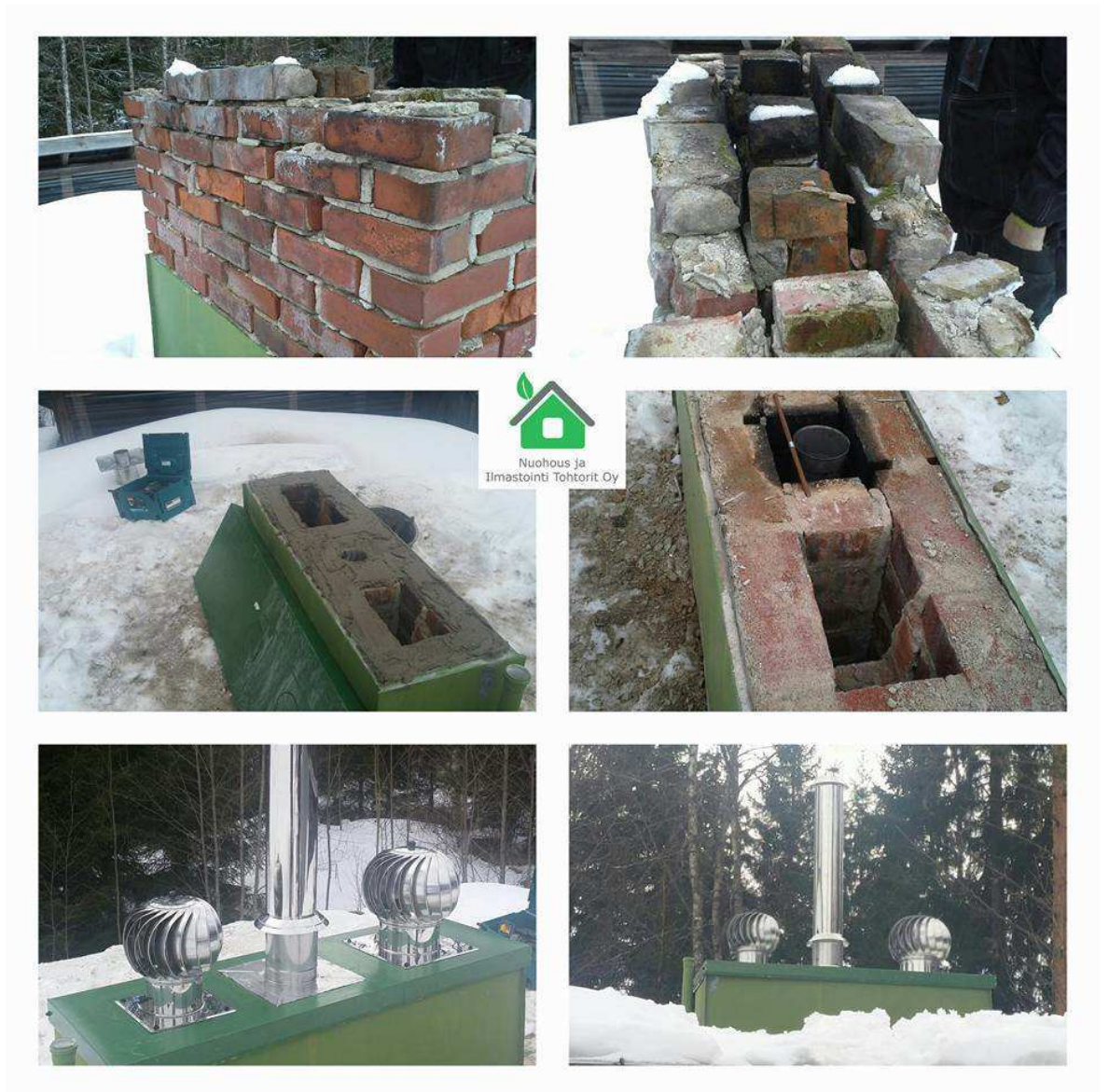
Kuvasarja 1. Kuvasarjassa esitettynä hormien saneerauksen vaiheet sisäpiippua asennettaessa.
